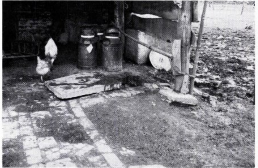
Figuur 2. Waterput (nummer 18) op het erf van een boerderij in het Geuldel bij Stokhem. De put is slecht geïsoleerd t.o.v. de buitenwereld.
